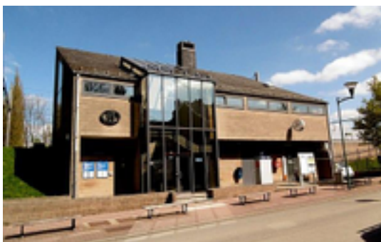
Afbeelding 1: Station Eupen (Bron: ArthurMcGill )
